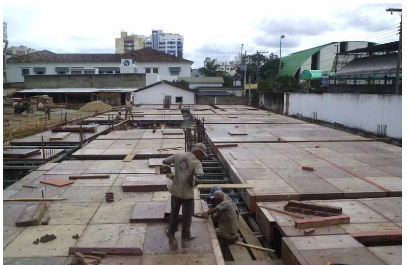
PILARES, VIGAS E LAJES CLÍNICA ESCOLA DE CAMPOS DOS GOYTACAZES - RJ
