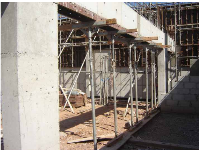
PILARES E VIGAS GARULHOS - SP
