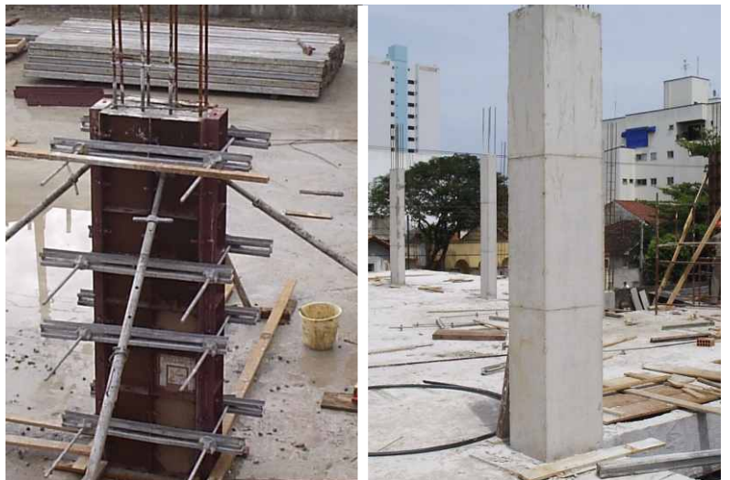
PILAR RETANGULAR PAINÉIS MONTADOS E ESTRUTURA CONCRETADA
