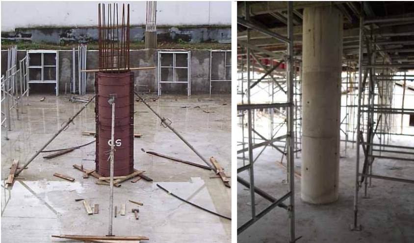
PILAR CIRCULAR PAINÉIS MONTADOS E ESTRUTURA CONCRETADA
