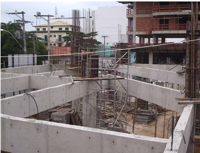
PILARES E VIGAS CABO FRIO - RJ
