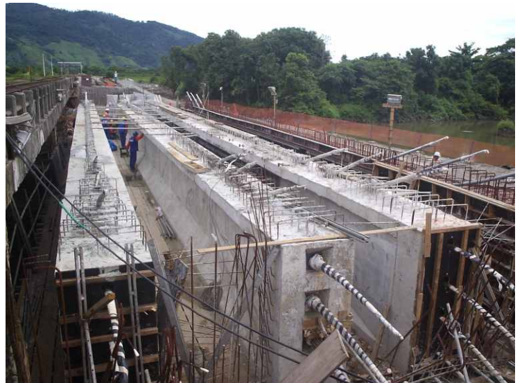
VIGAS PROTENDIDAS PONTE - BR 101 - RJ
