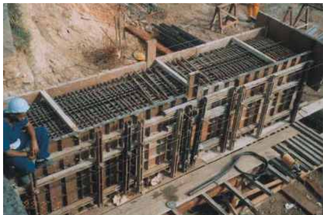
FUNDAÇÕES LINHA AMARELA - RJ
