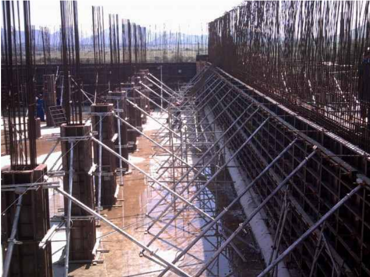
RESERVATÓRIO DO CABRAL NILÓPOLIS - RJ
