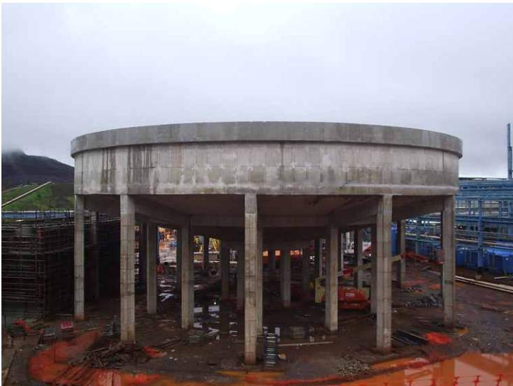
RESERVATÓRIO CIRCULAR ITABIRITO - MG
