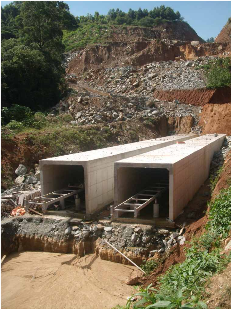
TÚNEL SANTANA DO PARNAÍBA - SP
