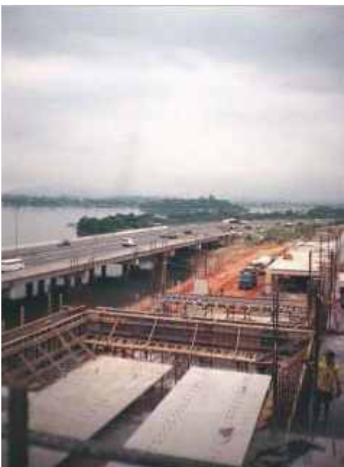
TERMINAL DE CARGA AÉREO AEROPORTO INTERNACIONAL - RJ
